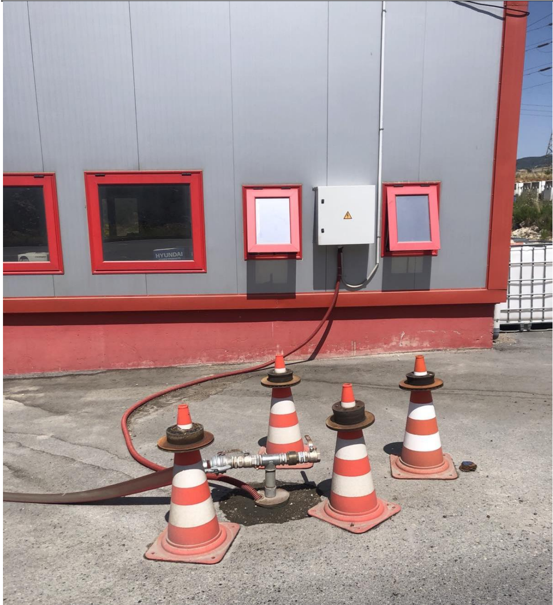
Εικόνα 2.4 Η θέση της υφιστάμενης (προσφάτως διανοιχθείσας) γεώτρησης. Διακρίνεται το λάστιχο πλήρωσης της υδροφόρας που λειτουργεί με χειροκίνητη εκκίνηση της λειτουργίας της υποβρύχιας αντλίας. Στα δεξιά, διακρίνεται η βάνα και η υποδοχή για την εγκατάσταση αγωγού μεταφοράς του αντλούμενου νερού στην υφιστάμενη δεξαμενή νερού-πυρόσβεσης.
