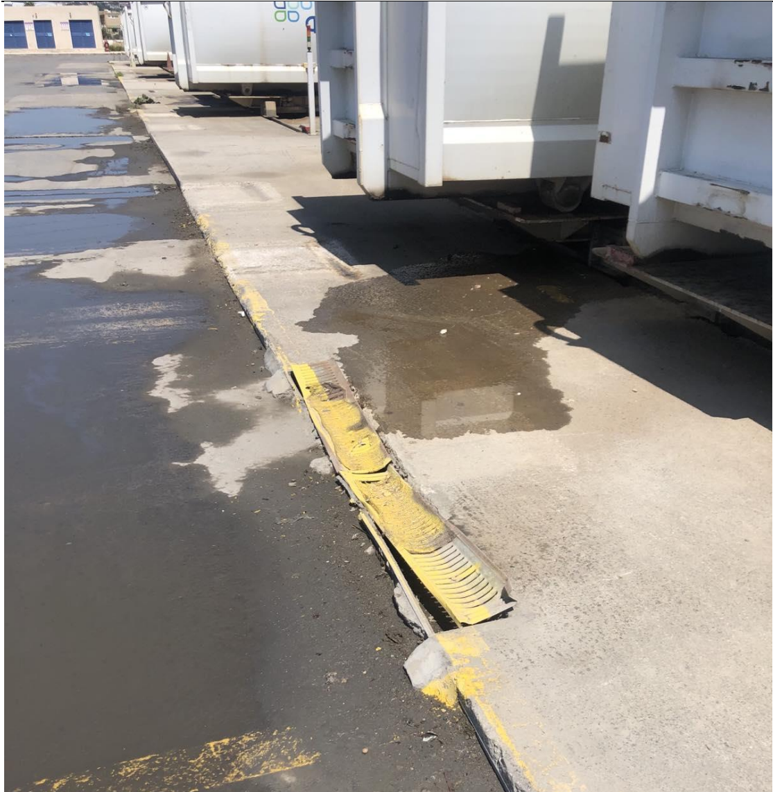
Εικόνα 2.3 Λήψη από την περιοχή έμπροσθεν των χοανών, όπου τοποθετούνται εσχάρες αποχέτευσης ομβρίων υδάτων, που έχουν φθαρεί. Η πλειοψηφία των εσχάρων έχουν αντικατασταθεί στο πλαίσιο της πρόσφατης εργολαβίας για την τοποθέτηση Μονάδας Προεπεξεργασίας Λυμάτων στον ΣΜΑ Ευκαρπίας.
