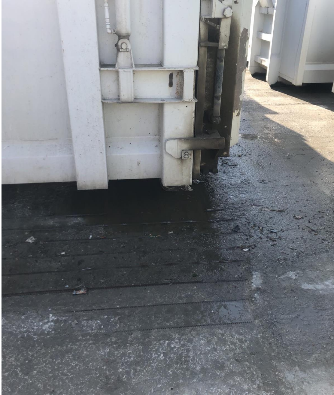
Εικόνα 2.9 Λήψη επί της πλάκας έδρασης των container στη θέση όπου λαμβάνει χώρα η διαρροή των στραγγισμάτων από αυτά. Διακρίνεται η αποκάλυψη του οπλισμού της άνω παρειάς της πλάκας που είναι εντονότερη πλησιάζοντας προς τη θέση διαρροής, αποδεικνύοντας την επικινδυνότητα του φαινομένου και την ανάγκη λήψης μέτρων αντιμετώπισής του.
