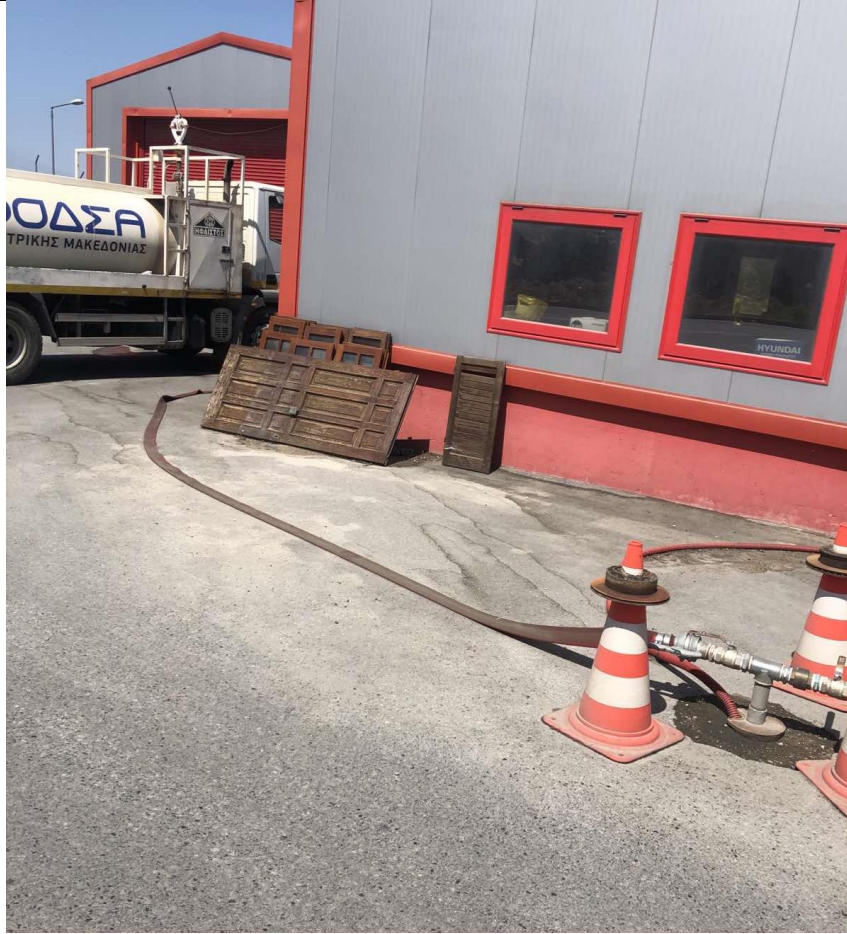
Εικόνα 2.5 Αποψη της θέσης της υφιστάμενης (προσφάτως διανοιχθείσας) γεώτρησης όπου διακρίνεται το λάστιχο που μεταφέρει το αντλούμενο νερό στην υδροφόρα.
