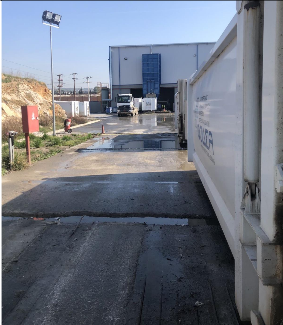
Εικόνα 2.7 Λήψη επί της πλάκας έδρασης των container. Διακρίνονται εκτεταμένες βλάβες στην επιφάνεια της πλάκας, όπως είναι η εμφάνιση του οπλισμού της άνω παρειάς της, λιμνάζοντα επιφανειακά ύδατα (στραγγίσματα & όμβρια ύδατα) που δεν απορρέουν φυσικά, διεύρυνση των αρμών συστολής και διάφορες επιφανειακές ανωμαλίες.
